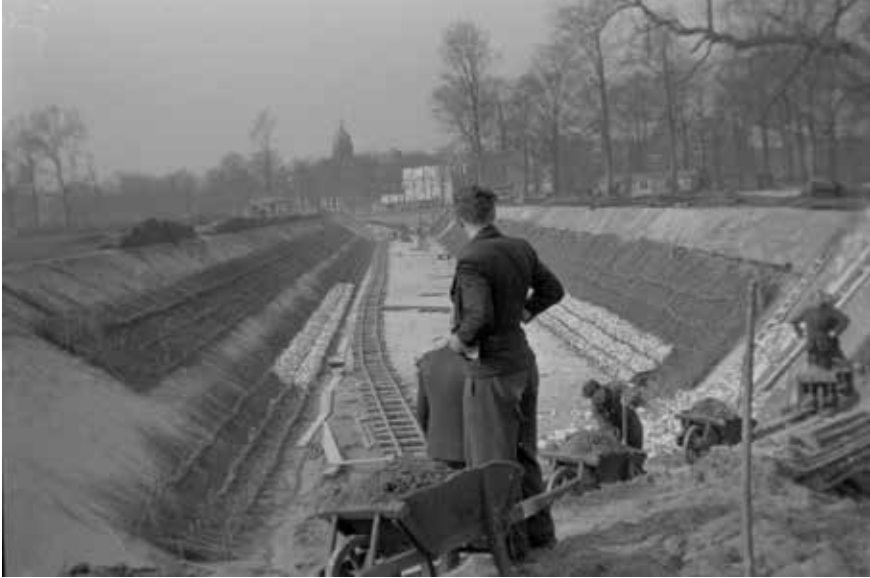
De aanleg van de tankgracht op het Malieveld begin 1943
