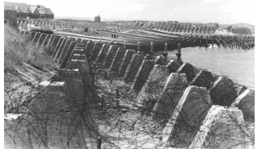
Tankversperringen in de voorhaven (augustus 1945)
