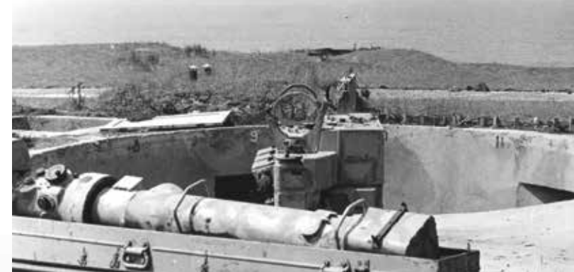
Bedding met afstandsmeter van de vuurleidingsbunker type FL 311 twee maanden na de bevrijding
