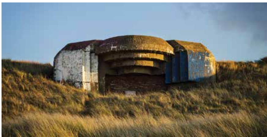
Eén van de vier geschutsbunkers type 671
